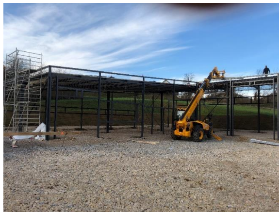
Montage de la toiture
