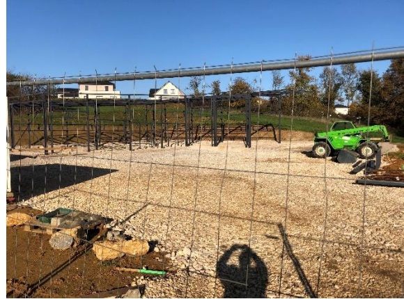
Montage de la structure métallique
